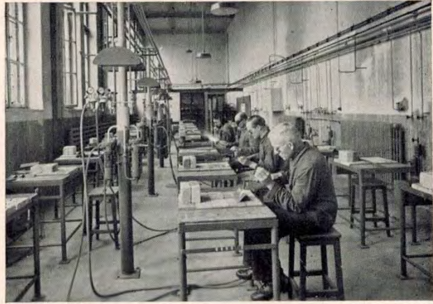
Schweißtechnische Lehr- und Versuchsanstalt: Halle für Autogenschweißung (Aufnahme der Landesbildstelle Hamburg)
