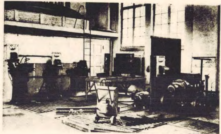
LABORATORIUM FÜR ELEKTROSCHEISSUNG
