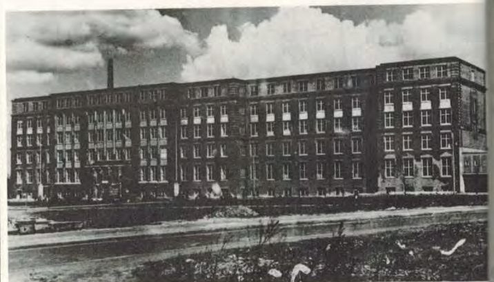
Hauptgebäude nach dem Wiederaufbau,
